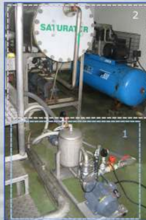
Pompa NIKUNI (1) w porównaniu z konwencjonalnym systemem napowietrzania (2)
