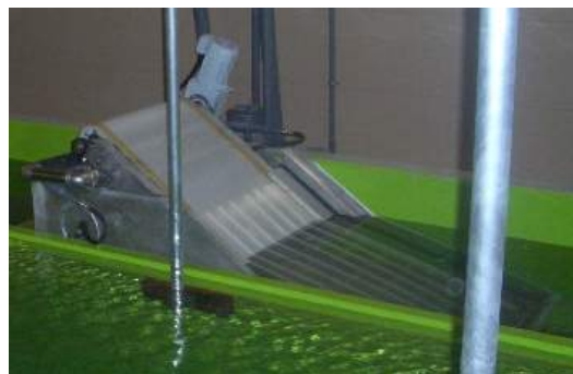
Filtr SFK zamontowany na farmie rybnej
